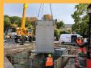
Octobre - colonnes de tri enterrées à Sassay, St-Aignan et Montrichard Val de Cher
