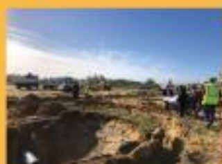
Septembre - lancement des travaux de la nouvelle déchèterie de Contres
